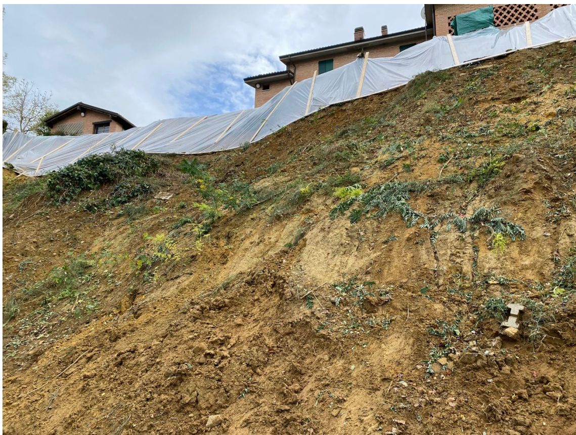
Foto 5a, 5b – Viste dell'intervento anti-erosivo lungo il ciglio superiore della frana
