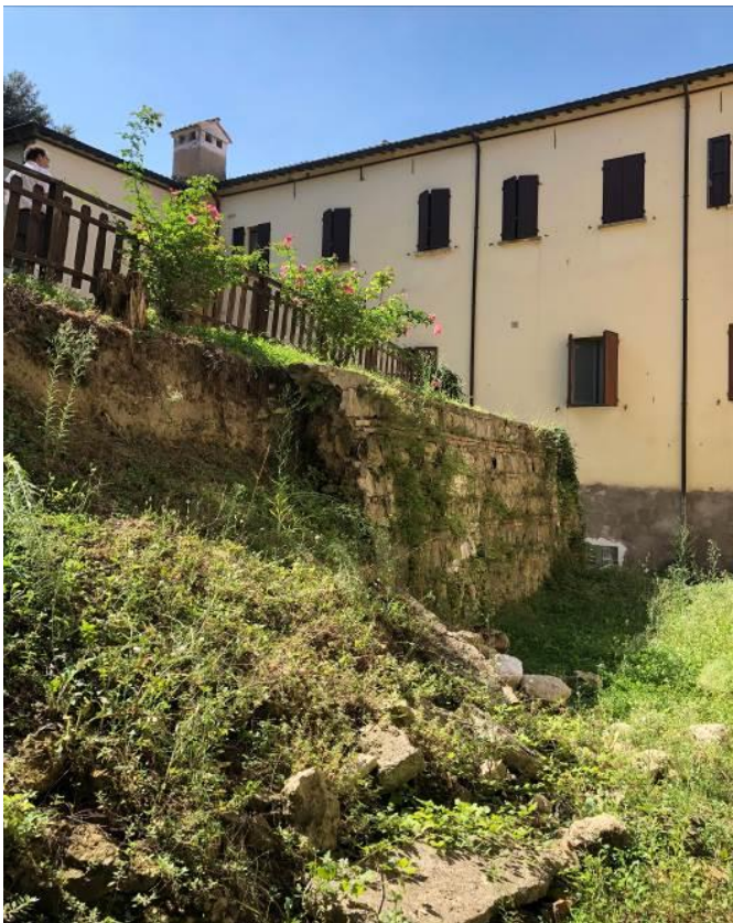
Porzione crollata del muro di contenimento in conci di pietra öspungoneö; terrapieno prevalentemente composto da terreno vegetale e da macerie costipate derivanti dal bombardamento subito dal Seminario nel 1944
