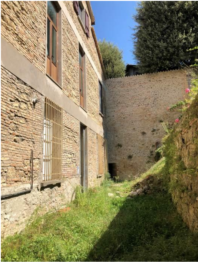
Vista dello scannafosso tra il corpo mensa ed il muro di contenimento che costituisce la corte rialzata.
