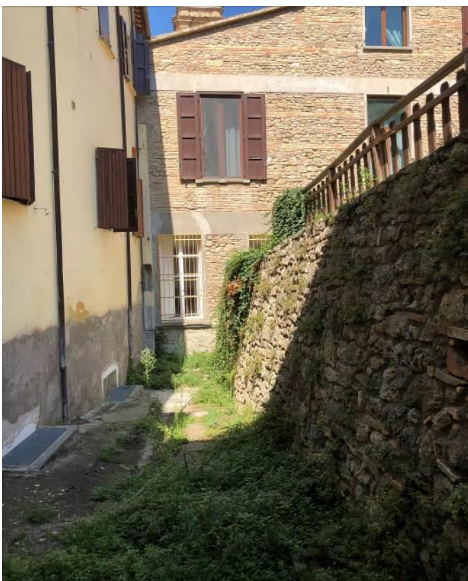
Vista dello scannafosso tra il corpo della foresteria ed il muro di contenimento della corte interna rialzata.
