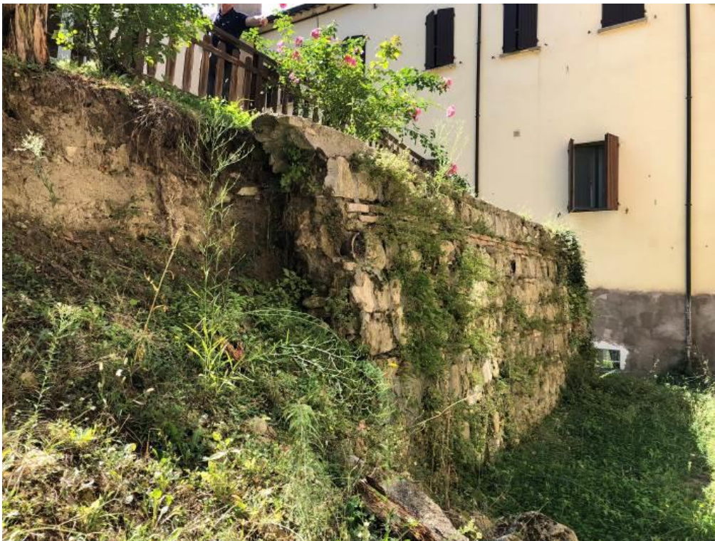
Particolari del crollo nel muro di contenimento della corte interna rialzata. Il terrapieno è prevalentemente composto da terreno vegetale e dalle macerie derivanti dal bombardamento subito dal Seminario nel 1944.
