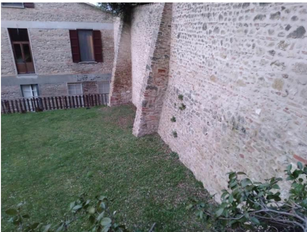
Vista del muro di cinta con contrafforti in conci di pietra calcarea e mattoni, a confine tra la corte interna rialzata e la superiore via Aldruda Frangipane.
