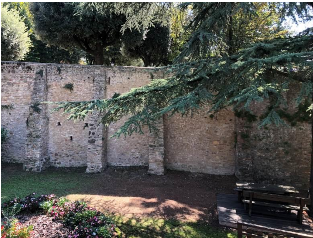
Vista della cinta muraria con contrafforti sul perimetro prospiciente la corte interna rialzata.
