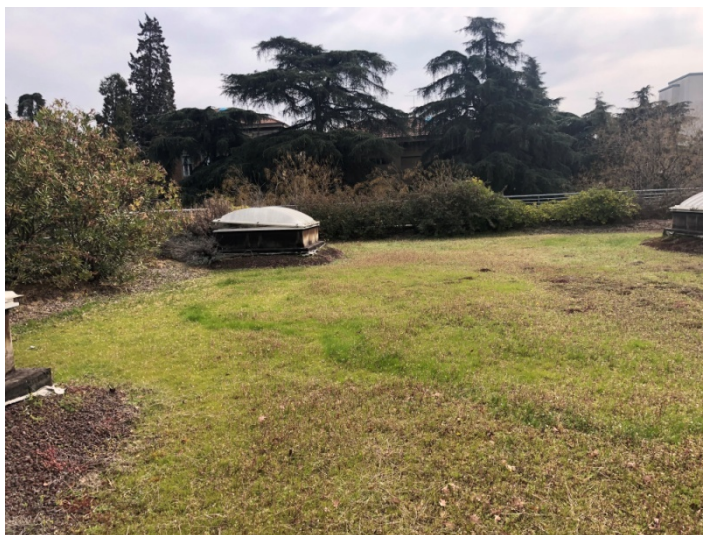
La copertura a verde pensile della Stazione Ecologica (riferimento per la prevista copertura del Centro Stella)
