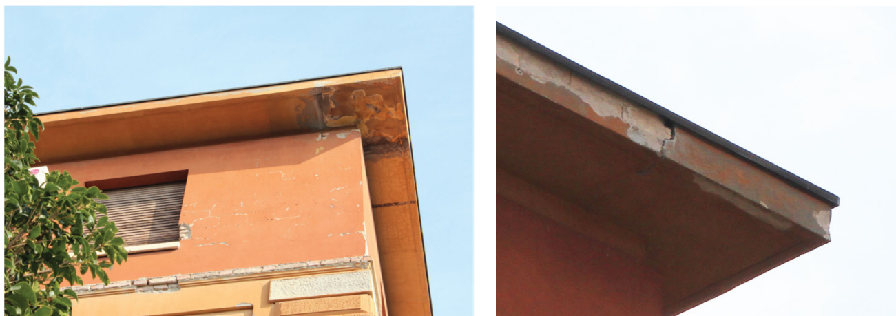
Figura 16 - Danneggiamenti dei cornicioni
