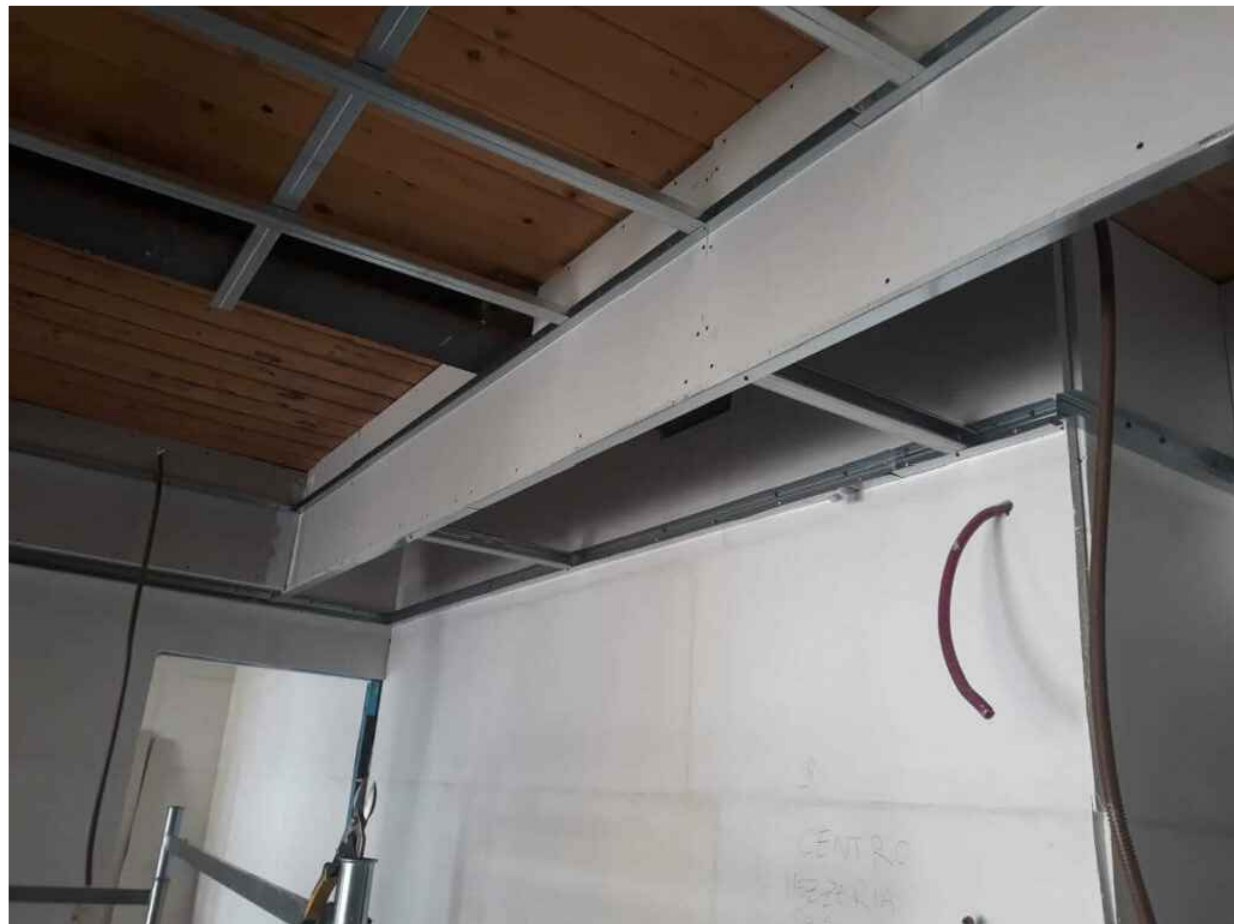
DETTAGLIO TIPICO REALIZZAZIONE VELETTA IN CARTONGESSO
