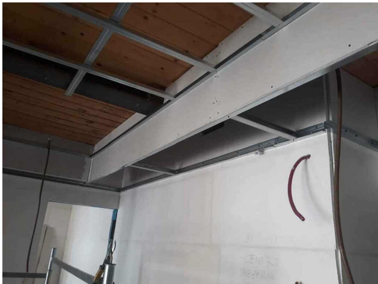
DETTAGLIO TIPICO REALIZZAZIONE VELETTA IN CARTONGESSO
